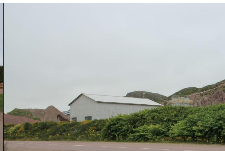
Hangar vu depuis l'extérieur du site
