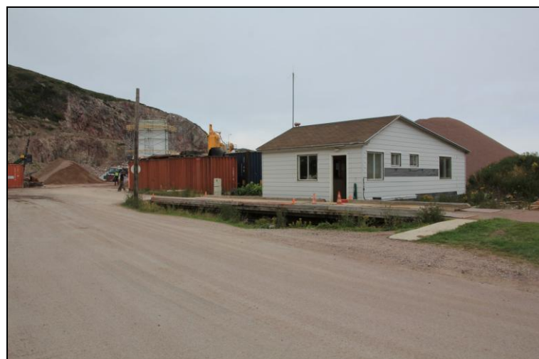
Pont bascule, local d'accueil et stockages à l'entrée du site, cuve de bitume de 300 t visible au fond
